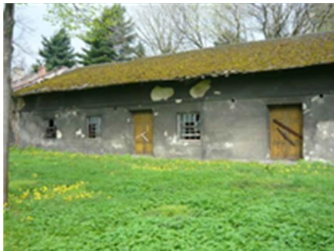
Stan obecny kaplicy
